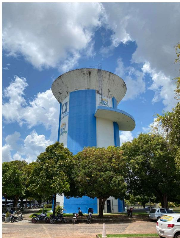
**FOTO Nº 04 – Reservatório de Concreto de 1.200m³**
