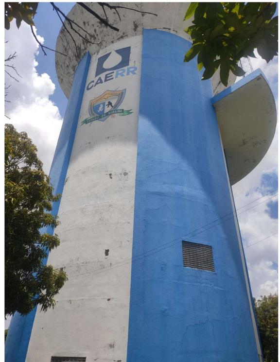
**FOTO N° 11 – Reservatório de Concreto de 1.200m<sup>3</sup>**
