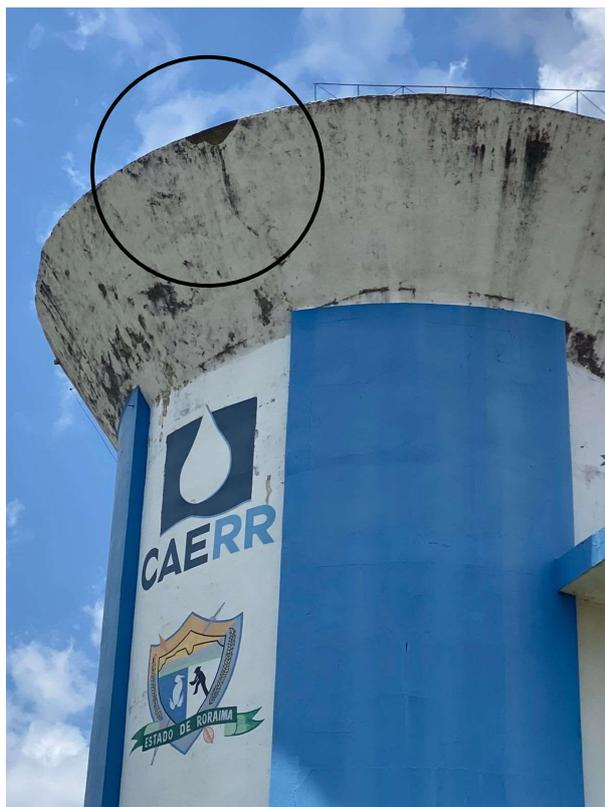
**FOTO Nº 01 – Reservatório de Concreto de 1.200m<sup>3</sup> – Detalhe do descolamento de parte do reboco**
