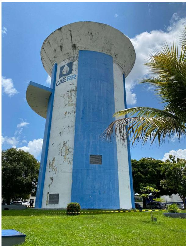
**FOTO Nº 02 – Reservatório de Concreto de 1.200m³ –
